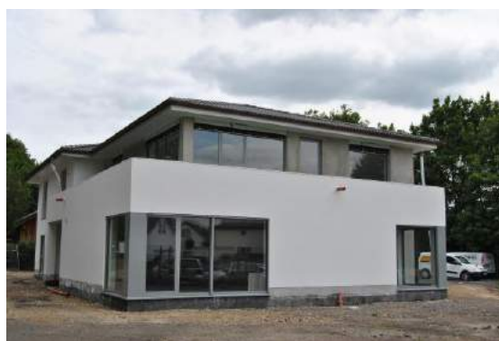
Die Bauarbeiten am „Wissenshaus Wanderfische“ stehen vor ihrem Abschluss. (Fotos: Christoph Heider)
