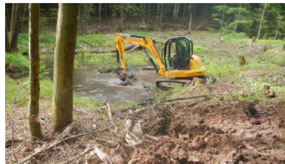
Der Schlammpeitzger (oben; Foto: Artenschutz in Franken® / Dr. Wolfgang Silkenat / Bezirk Unterfranken). Mit Hilfe eines Minibaggers werden die verlandeten Teiche wieder hergestellt (unten; Foto: Artenschutz in Franken® / Thomas Köhler und Klaus Weidner)
