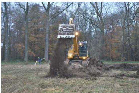
Naturschutz mit dem Bagger: Das Gewässerbett wird ausgehoben. (Foto: Christoph Heider)
